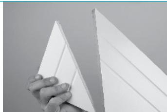
Vire a serra num ângulo de 45º e corte um pedaço da barra de rodapé de onde já foi retirado o acabamento de topo.
