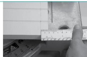
Após o corte, guarde o pedaço pequeno que sobrou, que deve ter um lado cortado em 45º e outro lado em 90º, pois esta peça será usada no acabamento de topo do rodapé.
